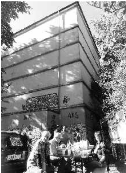
Der Bunker in der Schomburgstraße: Ein zukünftiger Energielieferant?
