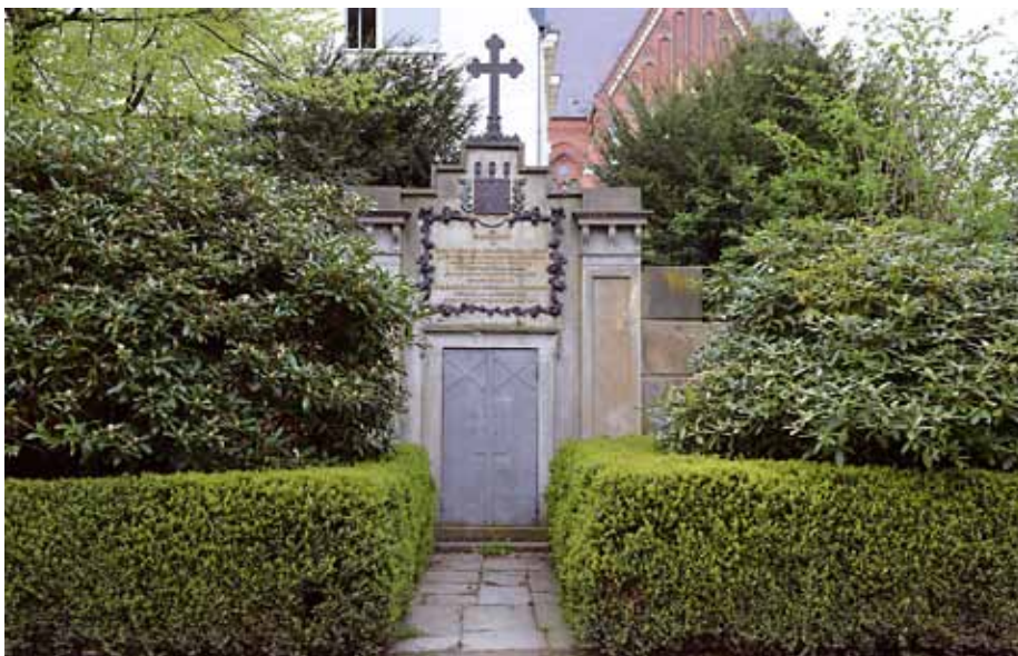
Zustand der Hügelgrabanlage Blücher im April 2015. Bereits 1973-1976 war eine zweite aufwendige Sanierung notwendig geworden. Heute präsentiert sie sich in einem sehr gepflegten Zustand.
